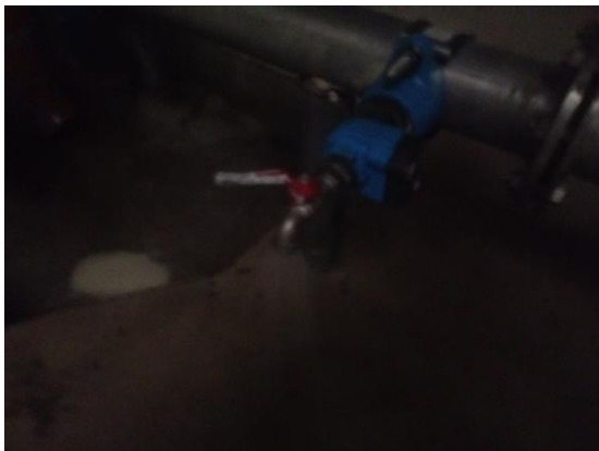
Abbildung 2: WVA Waldegg, Hochbehälter Wopfing, Blick zur Probenahmestelle Behälterablauf (Probe E2201545/008).
