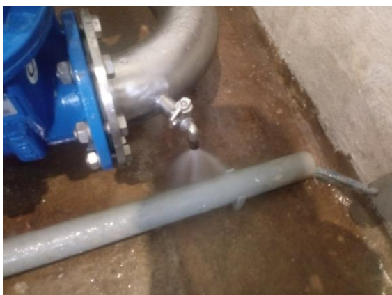
Abbildung 3: WVA Waldegg, Hochbehälter Wopfing, Gerät zur Desinfektion von Wasser mittels Ultraviolettstrahlung Dörrenbergquelle, Blick zur Probenahmestelle vor Desinfektion (Probe E2201545/001).
